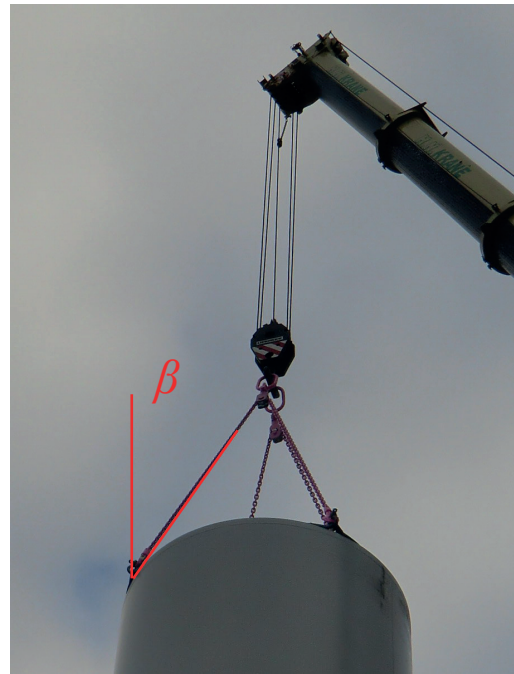
Fig. 6: Massimo angolo di tiro ammesso beta (= 45°)
